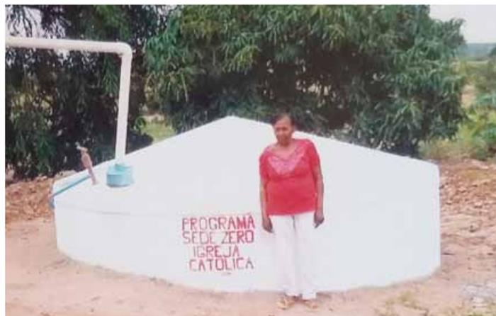
sur les photos, l'eau vient directement de la toiture et un petit filtre retient les impuretés. Toutefois, les premières eaux qui permettent de nettoyer la toiture ne sont pas récoltées. Pour faciliter l'extraction d'eau, une manivelle permet de retirer l'eau sans devoir ouvrir la citerne. Les matériaux sont achetés sur place, la manivelle est produite par des artisans locaux et le système a maintenant prouvé sa fiabilité depuis de nombreuses années.
