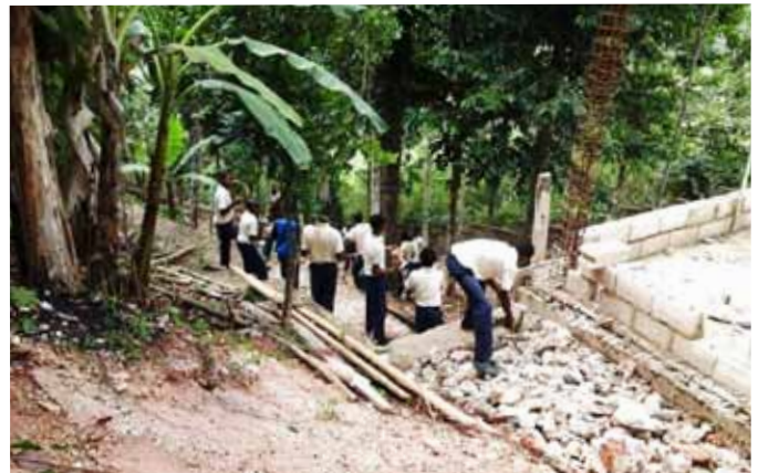
Deelname van de leerlingen van het college aan de constructie van het kippenhok
