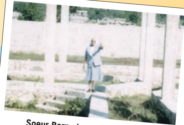
Soeur Bernadette au milieu des fondations de la future école primaire
